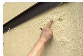
外壁の浮きやハガレをチェック。
