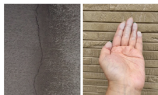
壁のひび割れ 手に白い粉がつく
