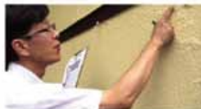
ドアや窓の開閉状況確認。 外壁の浮きやハガレをチェック。
