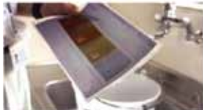
水回りの錆・漏れ、作動状況を実際に チェック。
