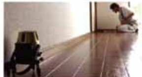
基礎部分や外壁・床のひび割れを 計測。建物の傾きも計測。
