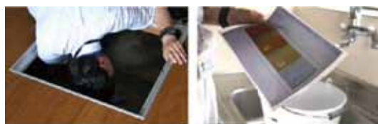
点検しにくい床下や小屋根、水廻りもチェック。
